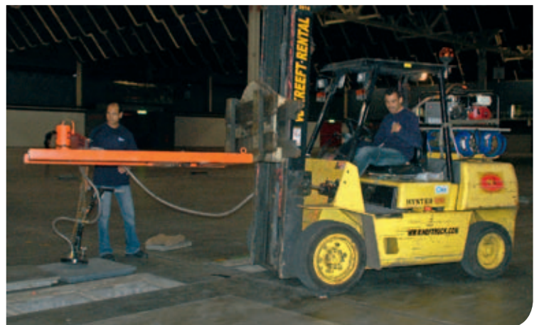
Zomerse werkzaamheden: het schoonmaken van de vloerputten.
